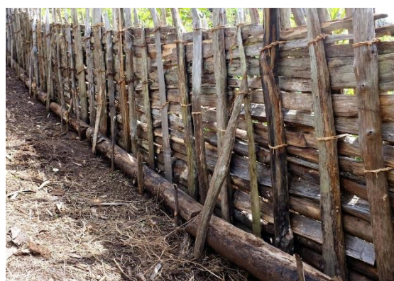
写真 8 タコラ・フェンスの構造
