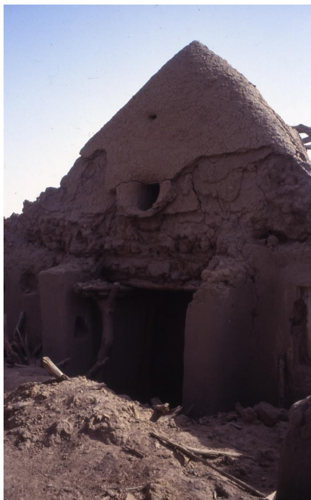
← : カラー写真6 ニャロの本スク 崩れたミフラーブの背面から 内部の構造がうかがえる
