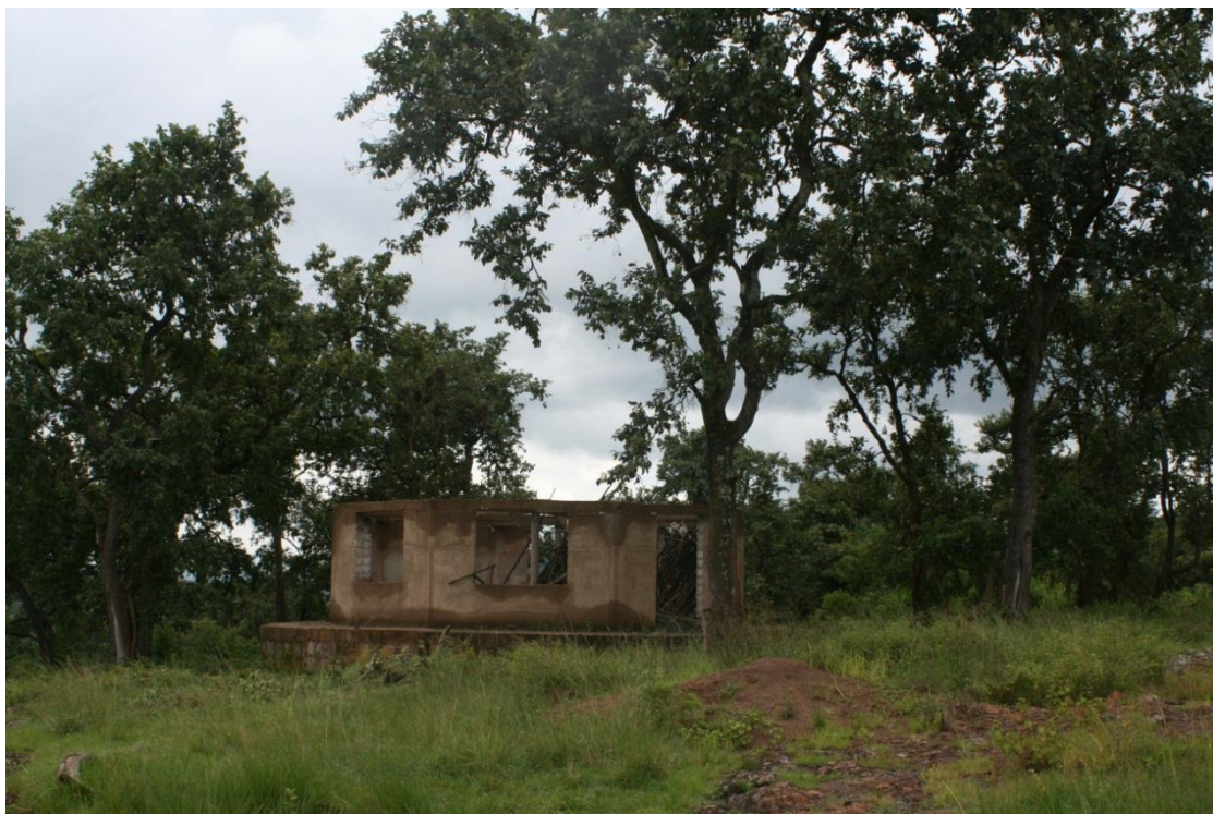
図6 建設中の「コーヒー博物館」(2010年8月筆者撮影)
