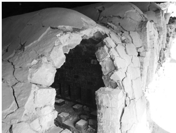
写真 1. 半壊した濱田窯の登り窯 (筆者撮影)
