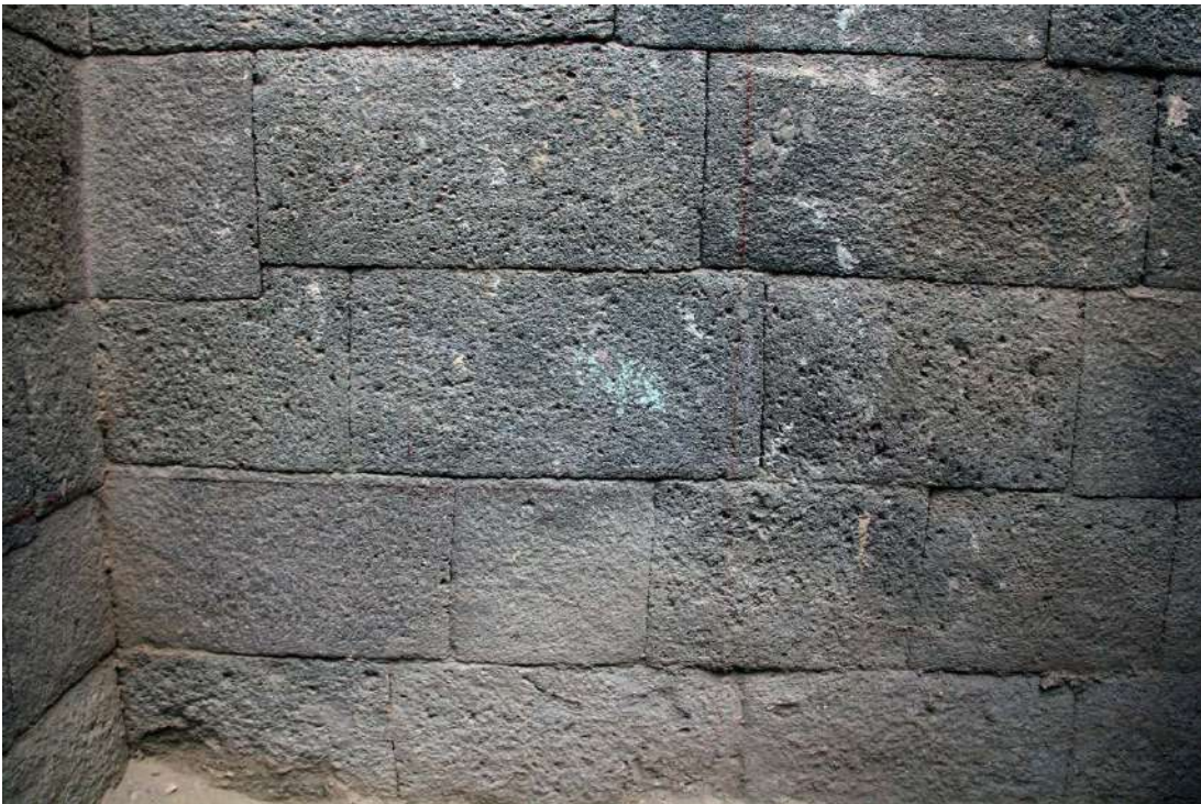
Figura 42. Paramento del muro con piedras labradas en el mausoleo (foto: José Ochatoma y Martha Cabrera).
