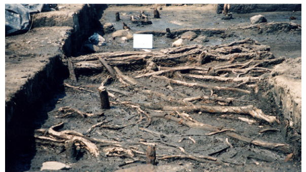
図9 ボルド(イスローテ)の建築工程・基礎づくりに使用された松や杉類の木材
