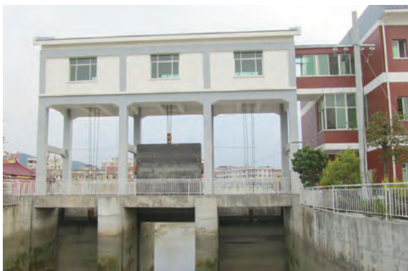
写真11 (開発後) 九龍江支流の潮汐管理のために設置された河口堰
