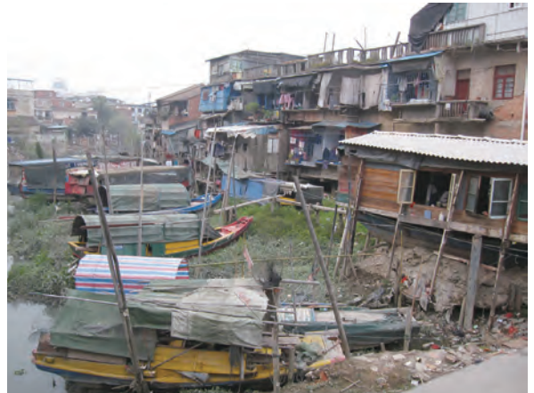
写真12 (開発前) 泥がむき出しになった九龍江支流の川岸
