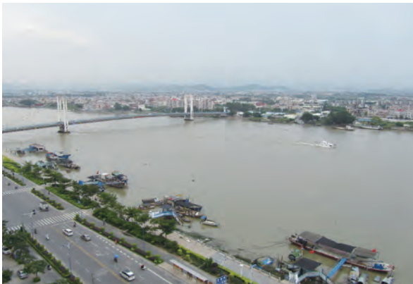
写真7 (開発後) 九龍江本流の畔に敷設された堤防と幹線道路
