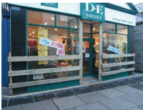
図6 設置されたバリケード 19
