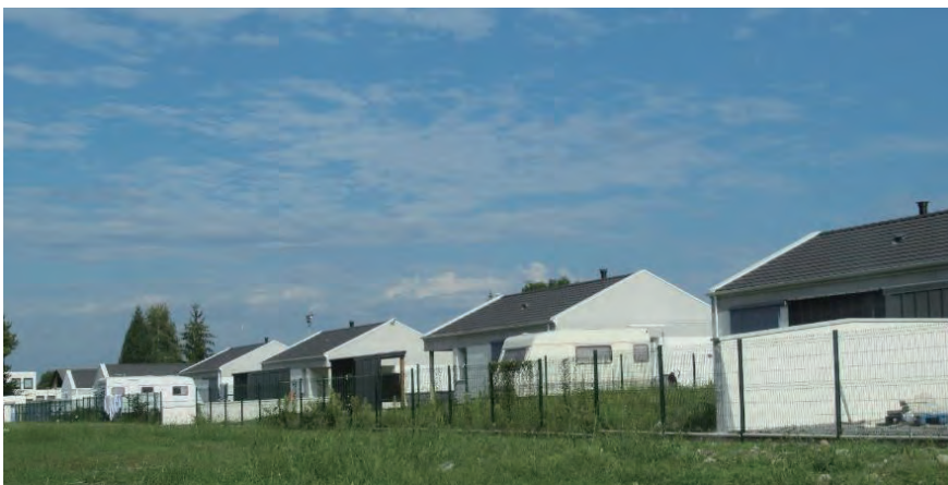
写真2 完成した第3適合住宅 (2018年9月筆者撮影)
