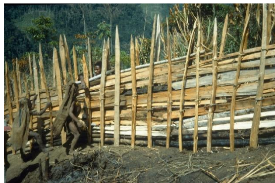
写真3 タコラ・フェンスの設置
