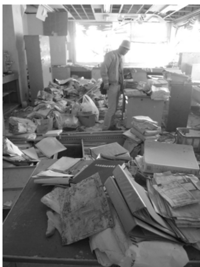
写真 2. 事務所 1 階の被災状況
