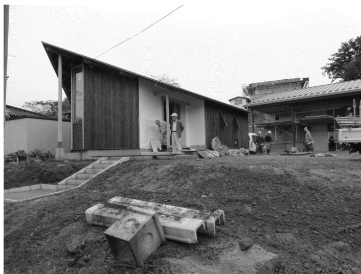
写真 10. 収蔵庫の建設
