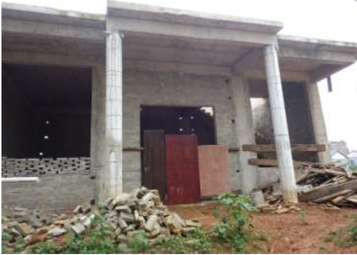
写真3 建設中の新しい建物 (2018年8月16日撮影)
