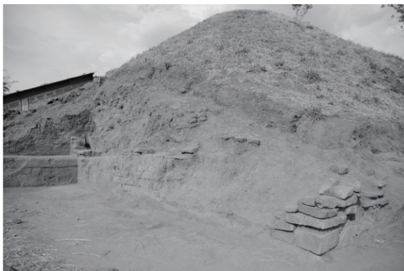
図10 サン・アンドレス遺跡5号建造物階段状ピラミッド南西角にみられる凝灰岩ブロックによる補修(筆者撮影)
