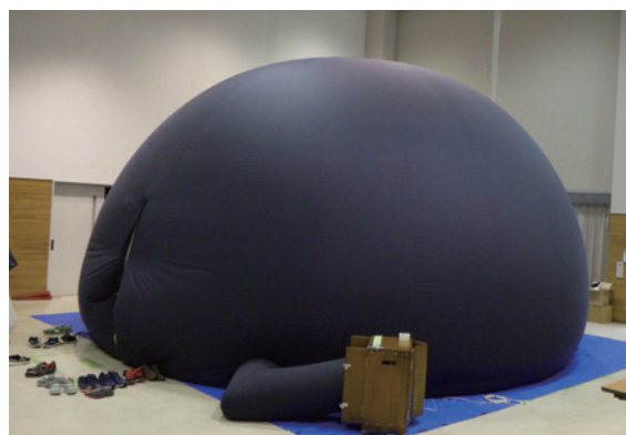
写真1 エアドーム式のプラネタリウム。手前の装置はエアを送る送風機(2021年11月喜界島にて)。
